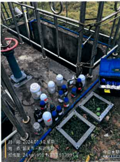
污水厂进水口
