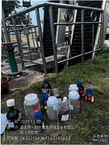
污水厂进水口
