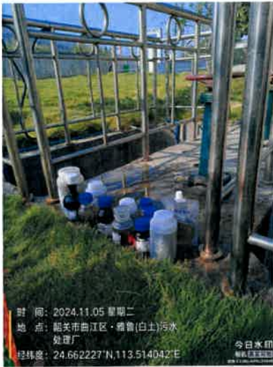
污水厂进水口
