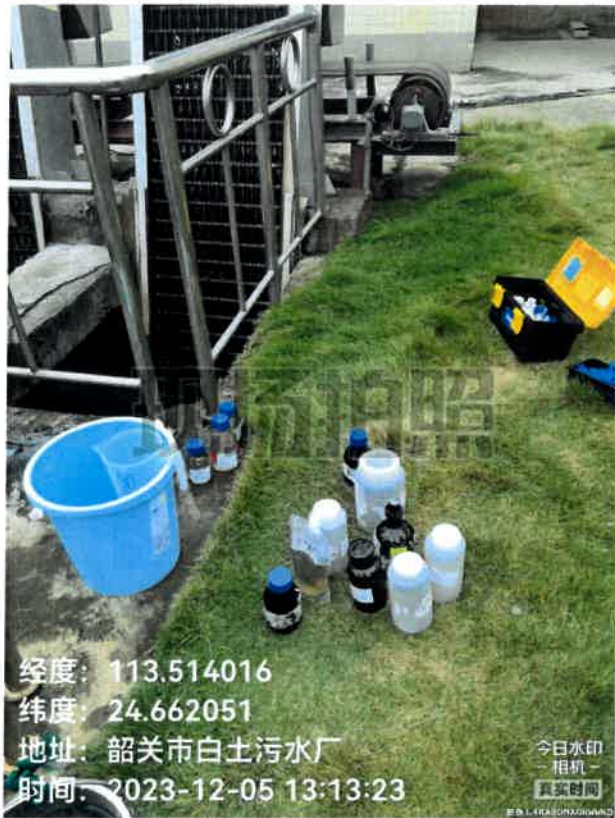
污水厂进水口
